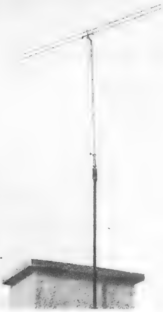
Bild 1. Freistehender Schleifendipol mit Bandableitung
