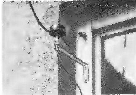
Bild 8. Blitzschutzanordnung mit Bandableiter
